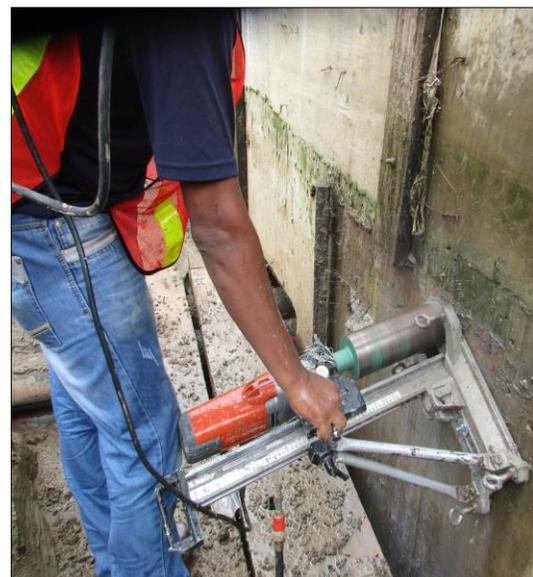
*Ilustración 7 Extracciones de Testigos.*
